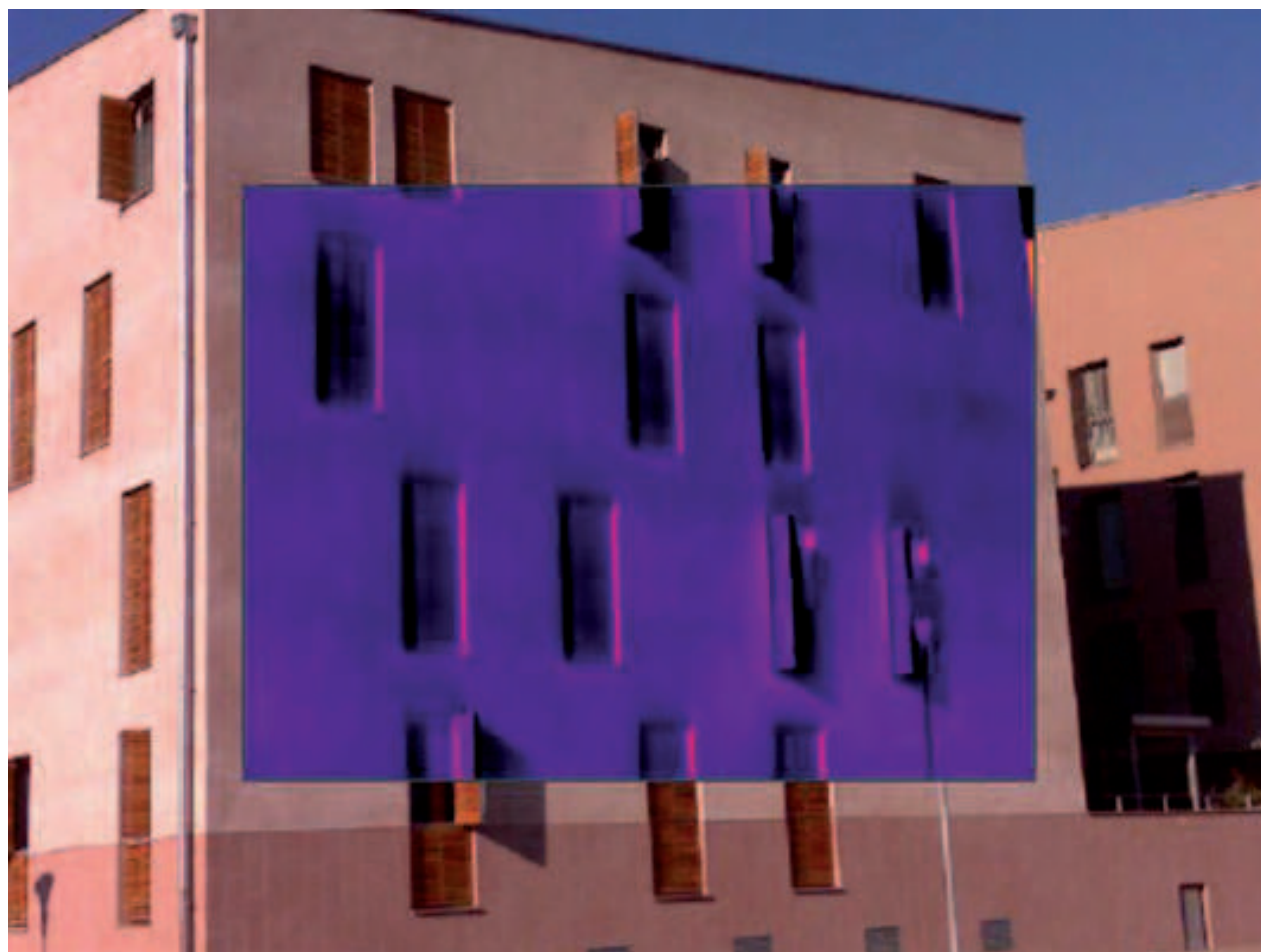
Termografia di un edificio del quartiere residenziale CasaNova - Bolzano
