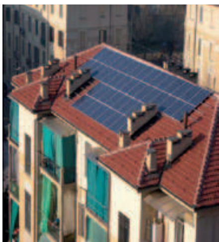
Edificio riqualificato, ATC di Torino
