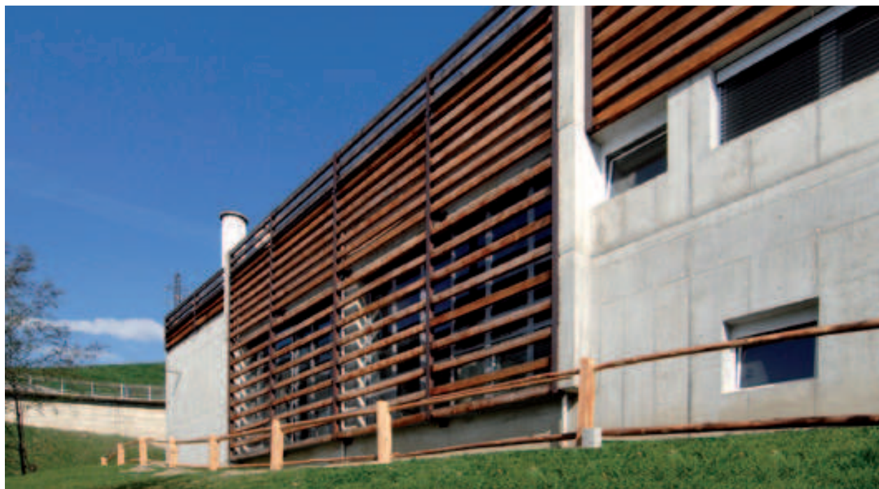
Impianto di teleriscaldamento a biomassa a Lazfons (BZ), Fonte SEL
