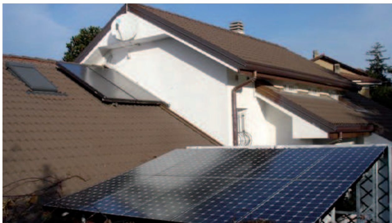
Abitazione con pannelli fotovoltaici e solare termico
